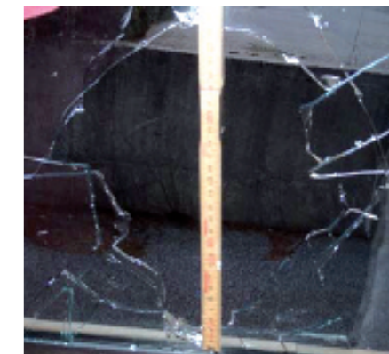
Figura 6 - Segni di effrazione su finestre
